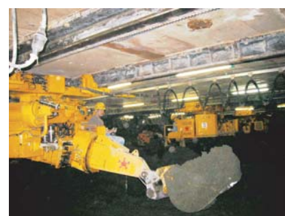
函内掘削状況
