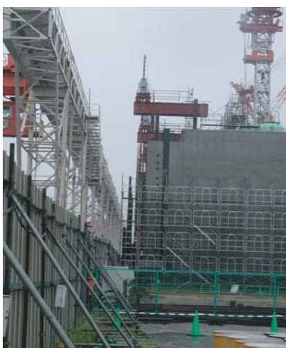
隣地クレーン設備との近接施工状況
