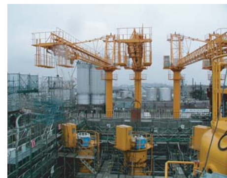
U2 施工状況②
