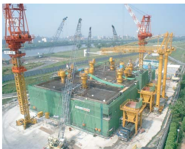
施工状況全景
