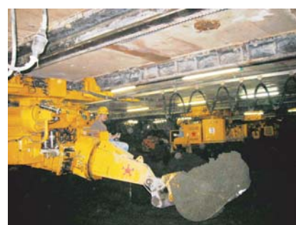
函内掘削状況
