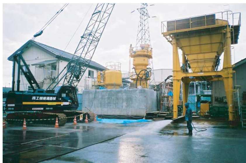
施工状況全景
