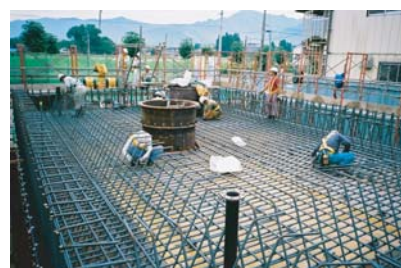
1ロット鉄筋組立
