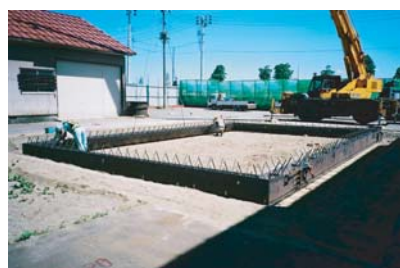
刃口金物据付
