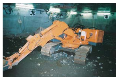
函内掘削状況
