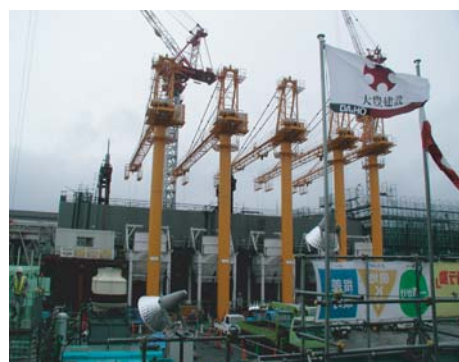
U2 施工状況①
