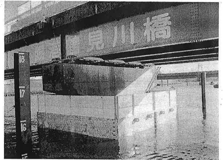
臨港鶴見川橋の工事では、1橋脚当たり補強が40日、仮締切設置・撤去が10日のサイクルで工事を進めた
