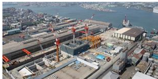
新若戸道路擁壁
