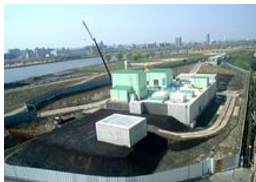
荒川町ポンプ場
