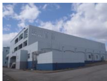
大和川ポンプ場
