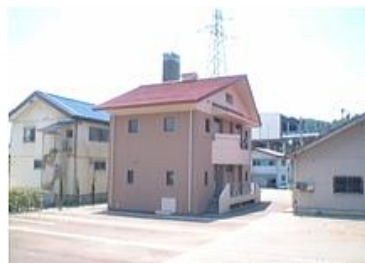
大和第一中継ポンプ場
