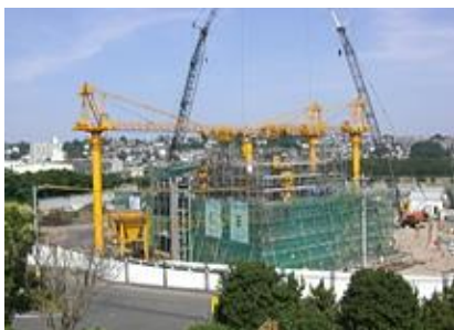
横浜湘南道路立坑
