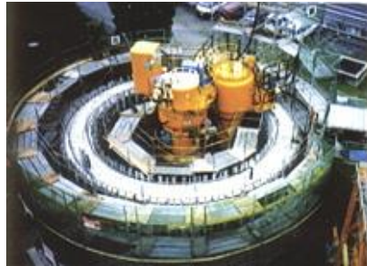
三河島～砂町間送泥管立坑
