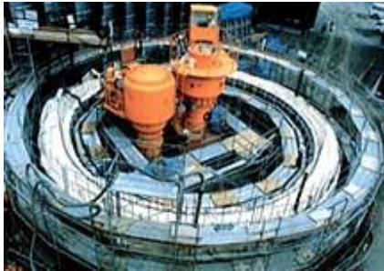
富津～柚ヶ浦間ガス導管立坑
