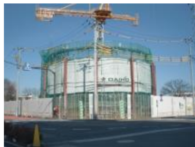
岩淵町付近枝線立坑
