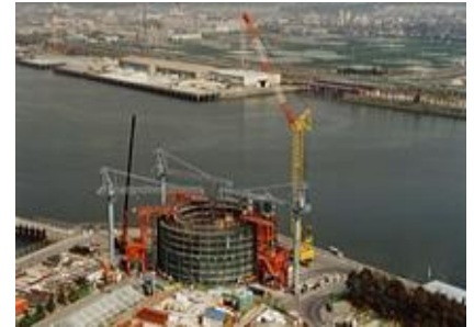
新名古屋火力発電所立坑
