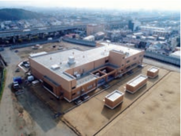
工事件名：松原ポンプ場築造工事 発注者：大阪広域水道企業団
