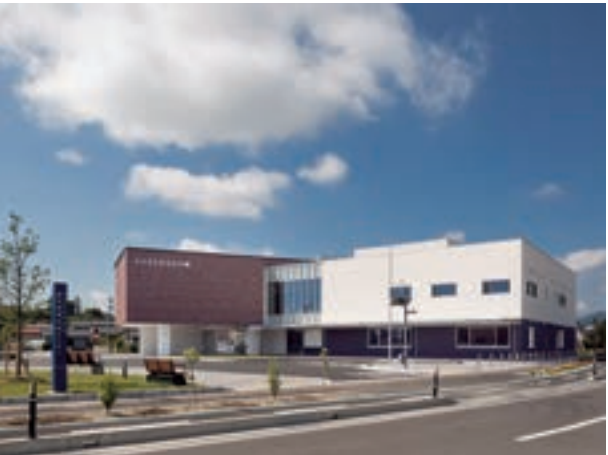
工事件名：平成28年度（債務）（仮称）坂元地区地域交流センター 新築工事 発注者：宮城県山元町
