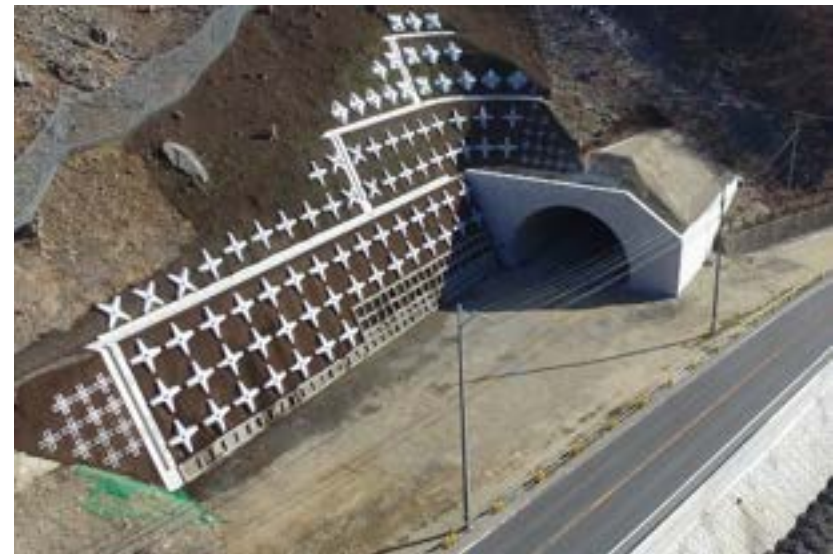
国道106号 腹帯地区道路工事【岩手県】
