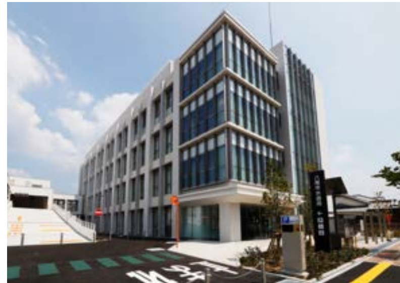
八尾市水道庁舎建設工事【大阪府】
