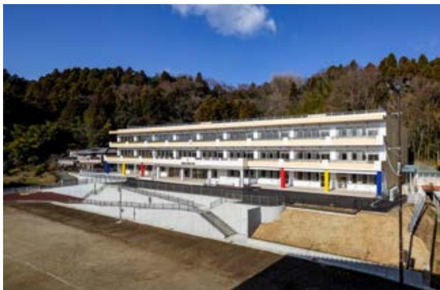
平成28年度利総給工第4号 利府小学校校舎建替え工事【宮城県】
