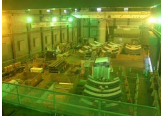
防音ハウス内部
