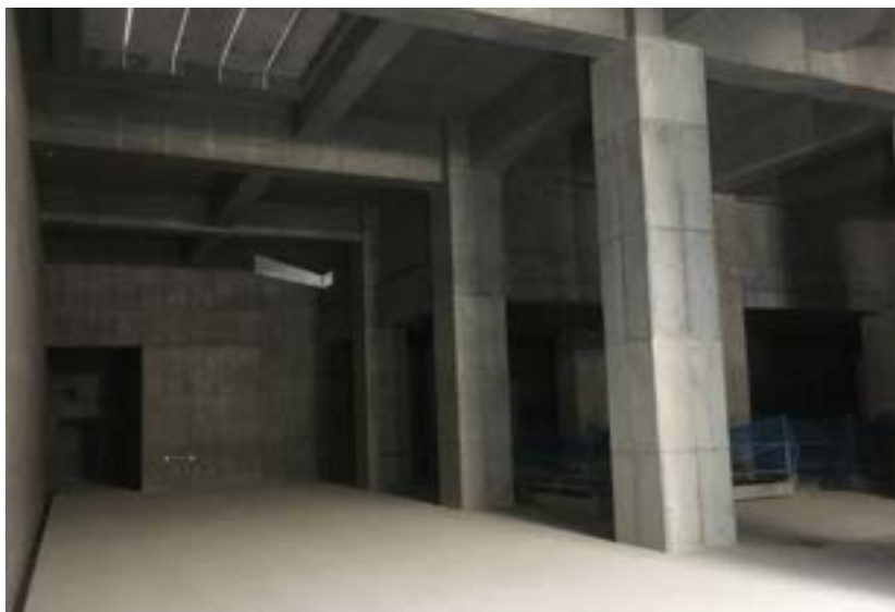
施工完了(内部)
