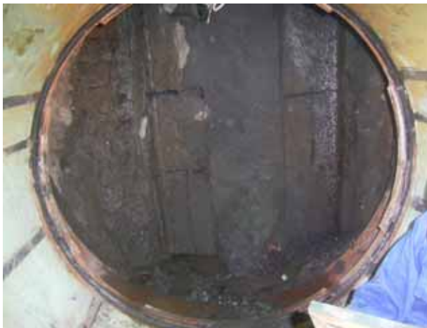
写真 5 鋼矢板撤去完了状況
