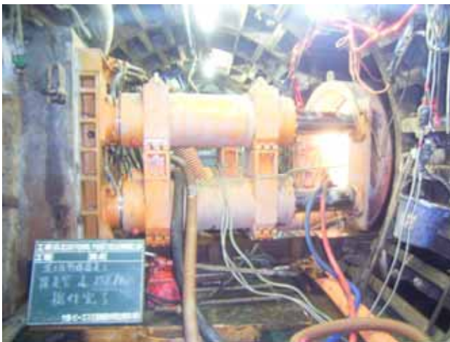
写真 3 元押しジャッキ・反力設備状況
