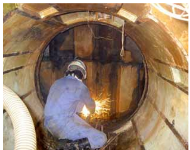
写真 4 鋼矢板切断状況
