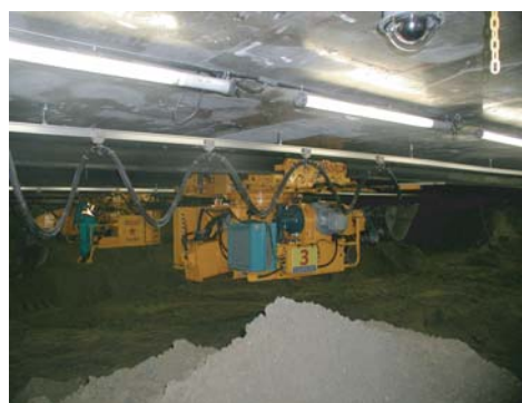
函内掘削状況 (DREAMII型)
