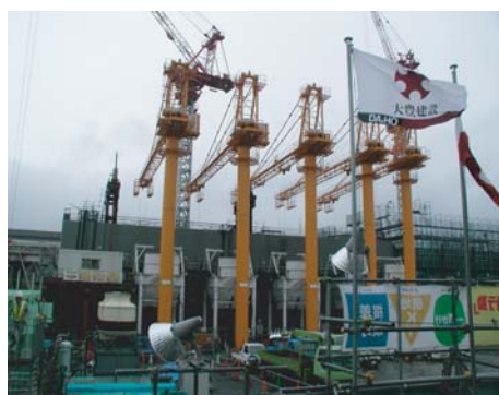
U2 施工状況①
