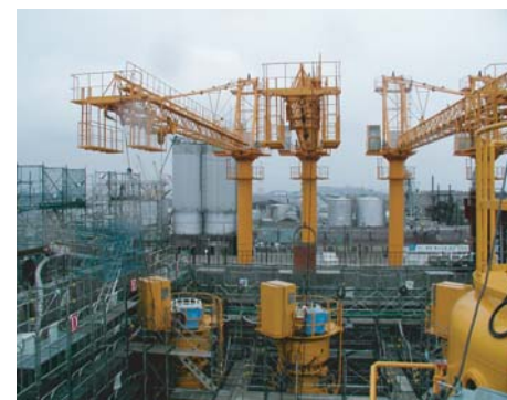
U2 施工状況②
