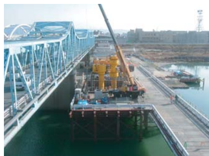
既設橋梁との近接作業状況
