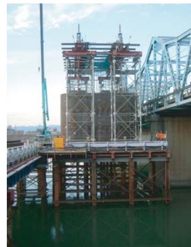
鋼殻設置状況
