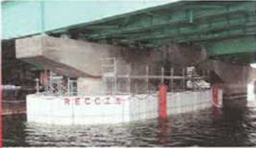
RECC工法によるP3の仮縮切
