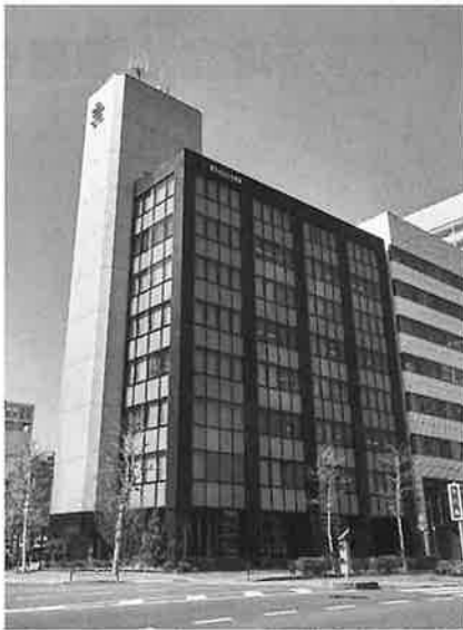
大豊建設本社。創立70周年を機にリニューアルした
