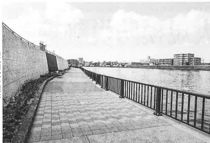
完成間近の護岸
