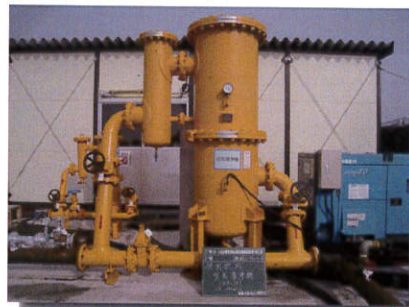
圧縮された空気に含まれている油分や水分を分離する機械です。
