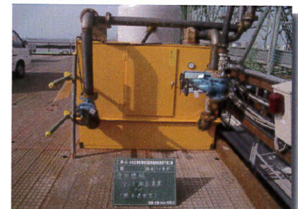
作業室内の空気圧を一定に保つ装置です。
