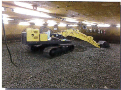
作業室の中で土や岩石を掘削したり集める電動式の機械です。
