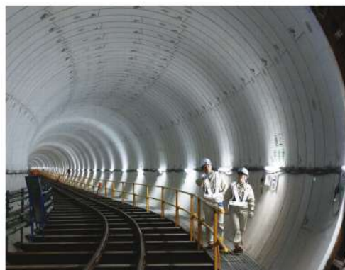
シールド工法で掘り進めた巨大下水道「江東幹線」。地下30mに直径6.5mのトンネルは全長4.2kmに及び、一東京区江東区
