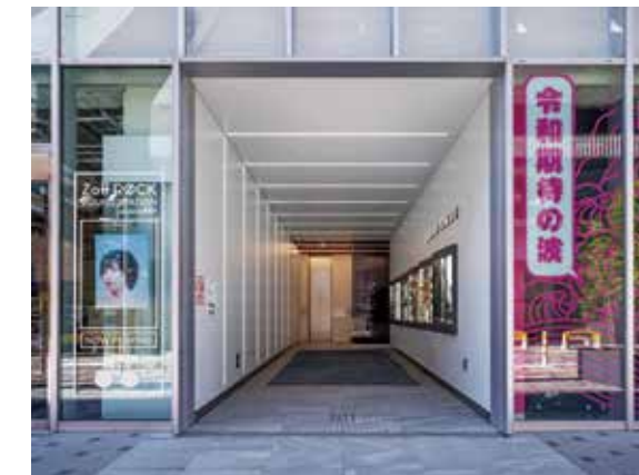
上/3階エレベーターホール 下/エントランス
