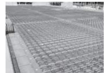
⑥配筋付型枠設置状況
