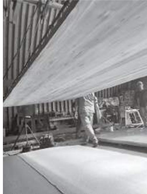
①配筋付製材型枠の試作
