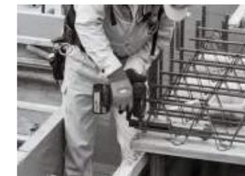
⑤配筋付型枠施工状況
