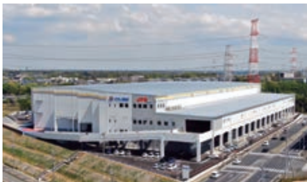
工事件名：(仮称) ナカノ千葉白井物流センター計画 発注者：ナカノ開発プロジェクト特定目的会社
