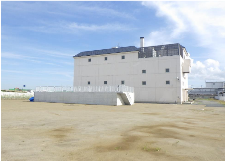
石巻市折立第一排水ポンプ場他5施設 復興・災害復旧建設工事【宮城県】
