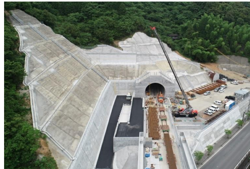
九州新幹線(西九州)、平間トンネル他【長崎県】
