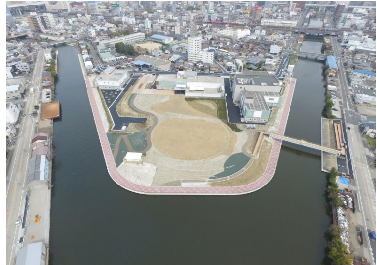
露橋水処理センター構内整備工事【愛知県】
