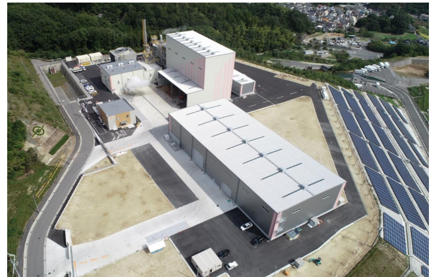
西風新都バイオマス発電所PJの内の 土木建築工事及び実施設計【広島県】
