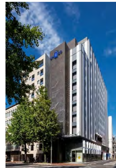
ホテルユニゾ博多駅博多口新築工事【福岡県】
