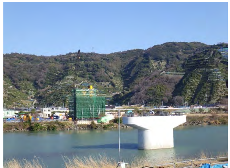
有田海南道路有田川1号橋下部工事【和歌山県】
