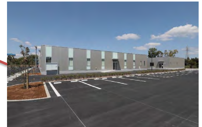
事務所棟・書庫棟
