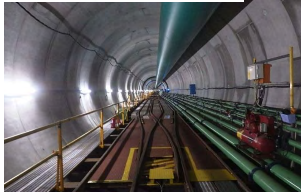
江東幹線工事【東京都】 (シールド工法)
