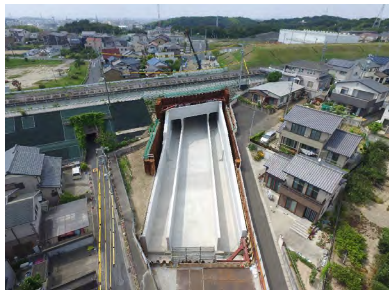
市道桶狭間勅使線第2号道路改良工事【愛知県】
