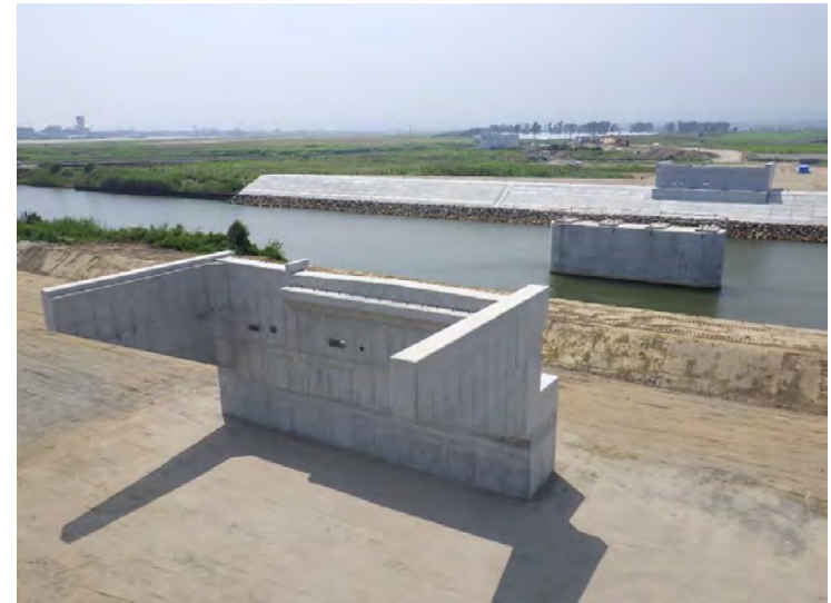
第92号 北釜大橋橋梁工事(下部工)【宮城県】
