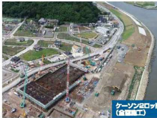
ニューマチックケーソン部分 (沈砂池ポンプ棟) (高さ 88.7m × 最大幅 41.25 m × 長さ 39m)
