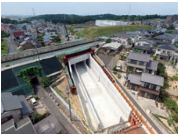
工事件名：市道桶狭間勅使線第2号道路改良工事 発注者：名古屋市緑政土木局
