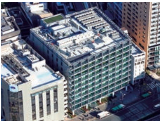
工事件名：麴町東急ビル建替計画 発注者：東京急行電鉄(株)
