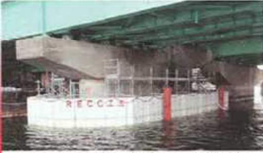
RECC工法によるP3の仮縮切
