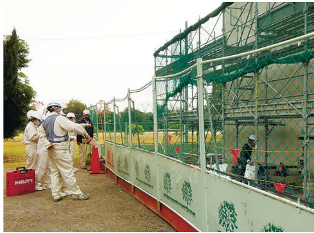
現場の施工状況を見学
