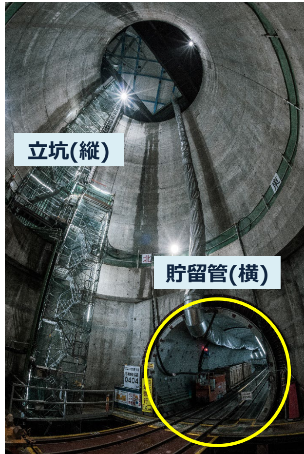
地下貯留管(立坑部)
