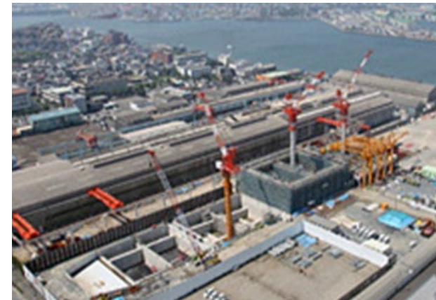
海底道路(陸上と海上の接続部分)
