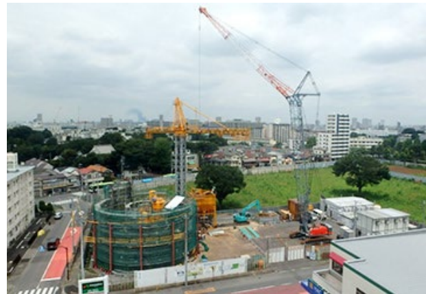
シールド立坑(施工状況)
