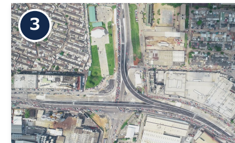
アビジャン立体交差 コートジボワール
