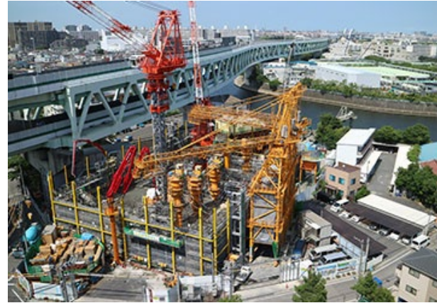
ポンプ場(施工状況)
