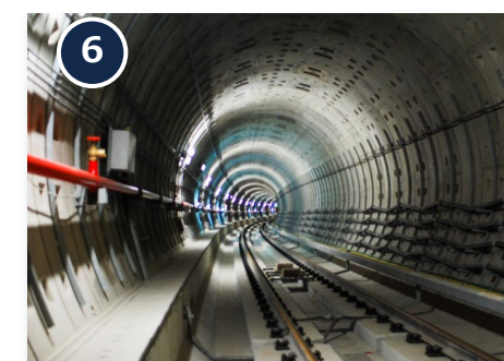
地下鉄 (シールド工法) 台湾
